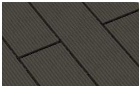
Vanwege de legwijze of de grootte van het terras kan het nodig zijn om de planken in de lengte stotend aan te leggen. Zorg voor een afstand van 8 mm tussen de kopse kanten.
